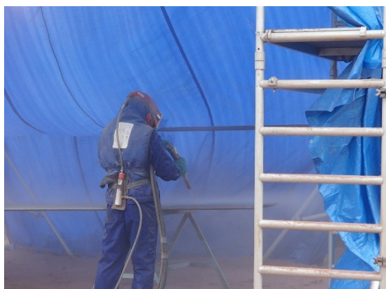
Na tak przygotowaną powierzchnię natrykuje się metal.
